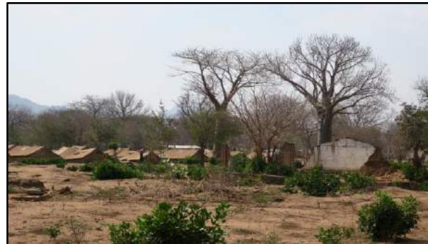
Foto N.º 3. Campo de Luwani: à direita, os destroços das fundações do antigo acampamento de Luwani provocados pela guerra civil, ao lado das tendas dos recém-chegados do conflito à esquerda, Outubro de 2016.
